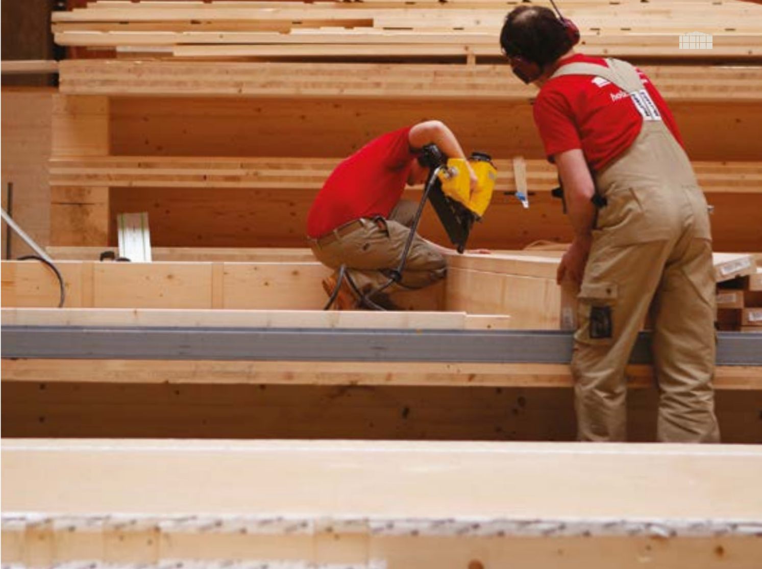
Stefan und Sepp bei der Vorfertigung der Holzriegelelemente.
